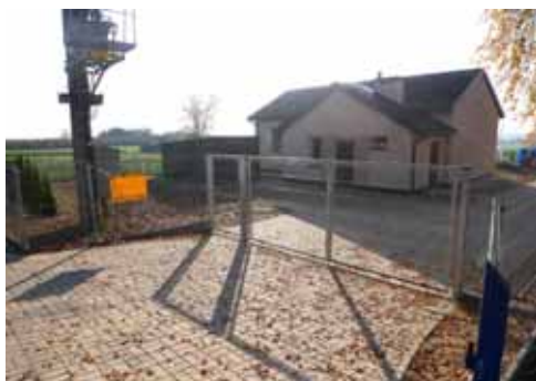
Stacja uzdatniania wody w Jastkowie
