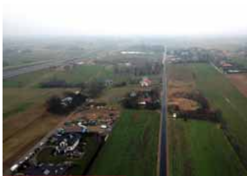
Przebudowa drogi w Marysinie
