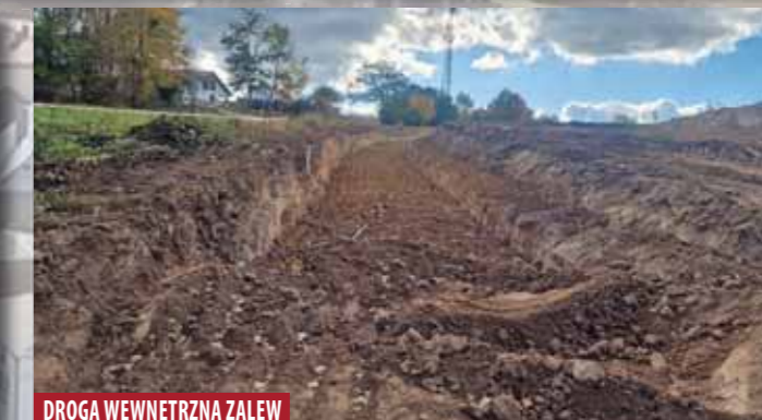
DROGA WEWNĘTRZNA ZALEW
